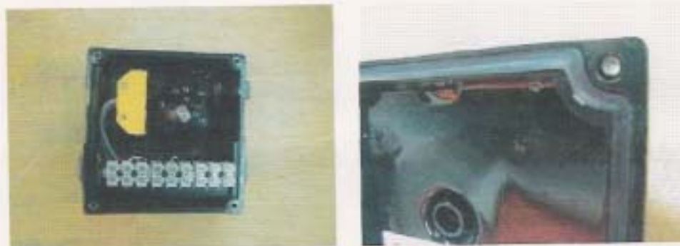
FIGURAS 13 e 14 - AUSÊNCIA DE CORROSÃO NOS COMPONENTES INTERNOS BORRACHA
